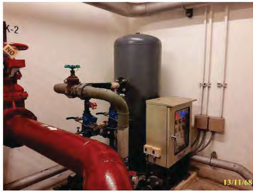
เครื่องปั้มน้ำ พร้อมถังสำรองน้ำชั้นดาดฟ้า
