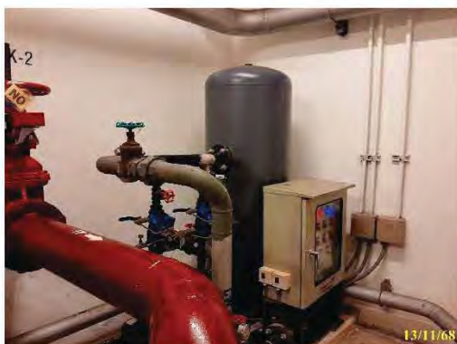
เครื่องปั๊มน้ำ พร้อมถังสำรองน้ำชั้นตาดฟ้า
