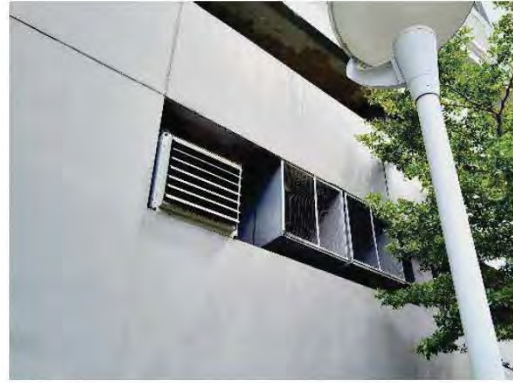
ระบบระบายอากาศชั้นใต้ดิน
