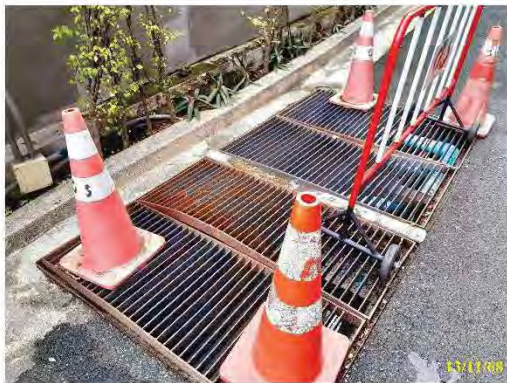
บ่อดักน้ำสุดท้ายก่อนระบายออกนอกโครงการ และตู้ควบคุม
